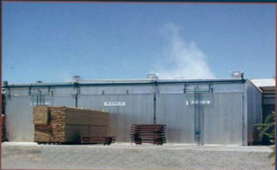
Los secaderos acelerados de la sexta generación hacen posible tiempos de secado muy cortos . Programas especiales de precalentamiento y acondicionado aseguran un secado uniforme y libre de tensiones, lo que permite la inmediata elaboración de la madera con procesos continuos.
