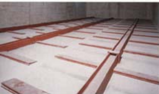
Descarga mediante suelo alimentador de empuje con accionamiento hidráulico
